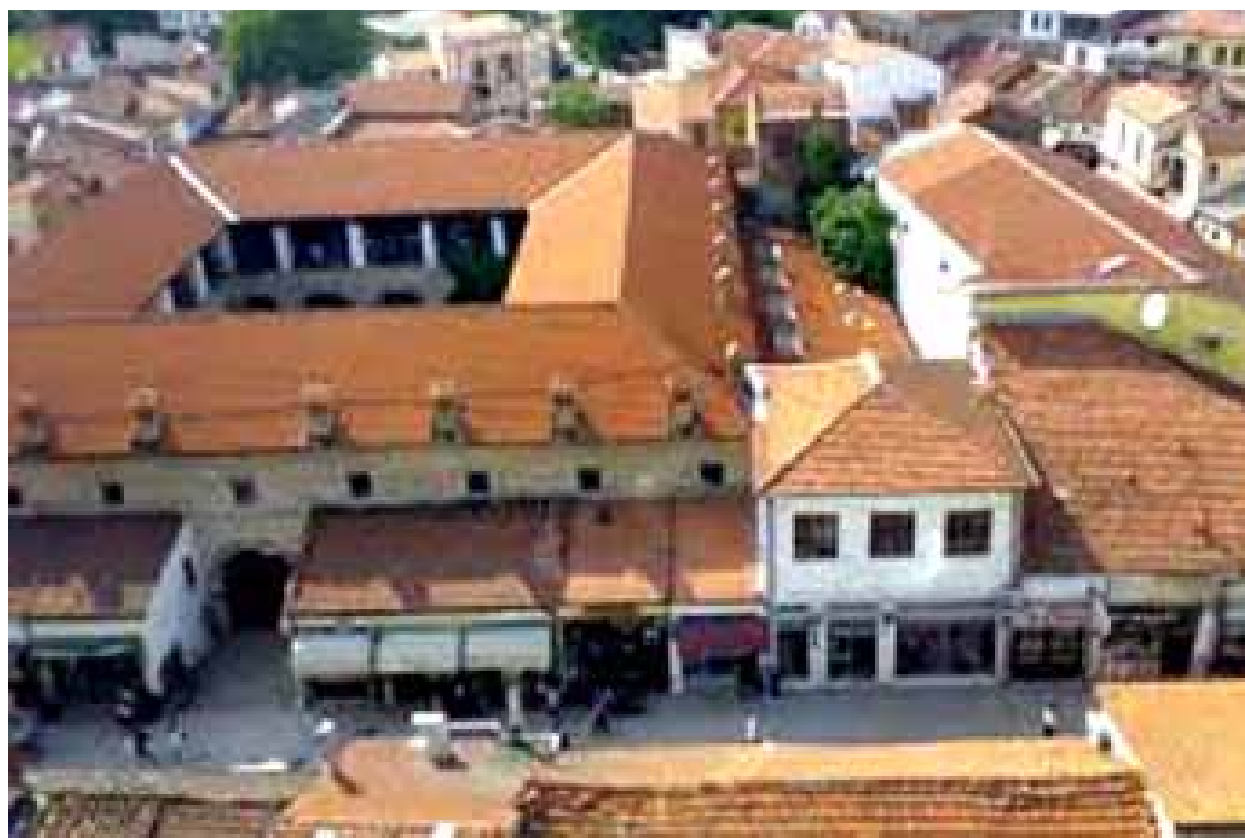
1968 - Реконструкција и ревитализација на урнатиот објект Сулијан во Старата скопска царшија
