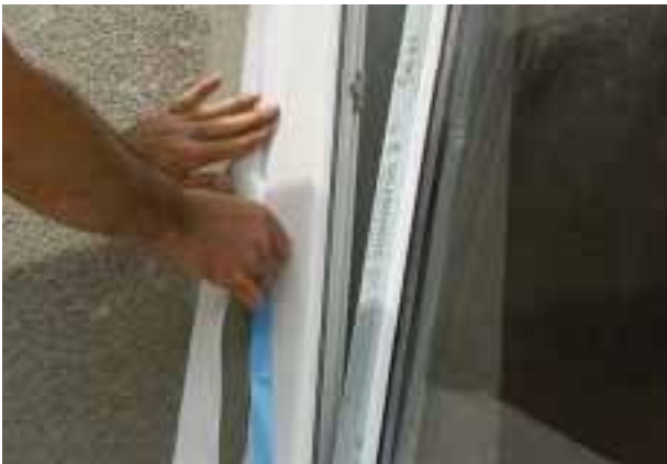
Водонепропусливост, но паропропусливост од надворешна страна. Начин со укр-лента
