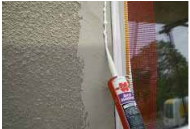
Водонепропусливост, но паропропусливост од надворешна страна. Начин со укр-лента
