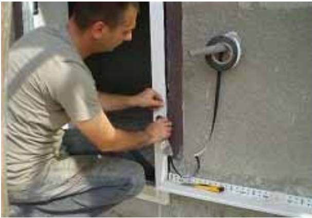
Водонепропусливост, но паропропусливост од надворешна страна. Начин со укр-лента
