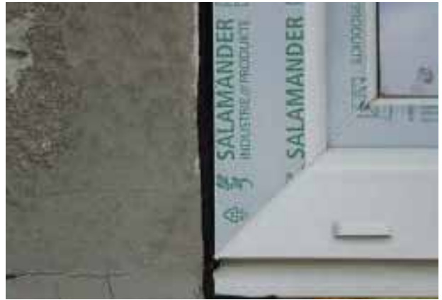
Водонепропусливост, но паропропусливост од надворешна страна. Начин со укр-лента
